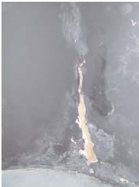
Treppenhaus Feuchteschäden
