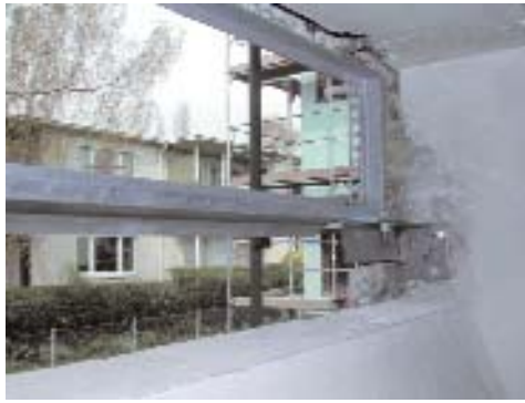
Sanierung Holzfenster Stahlfenster
